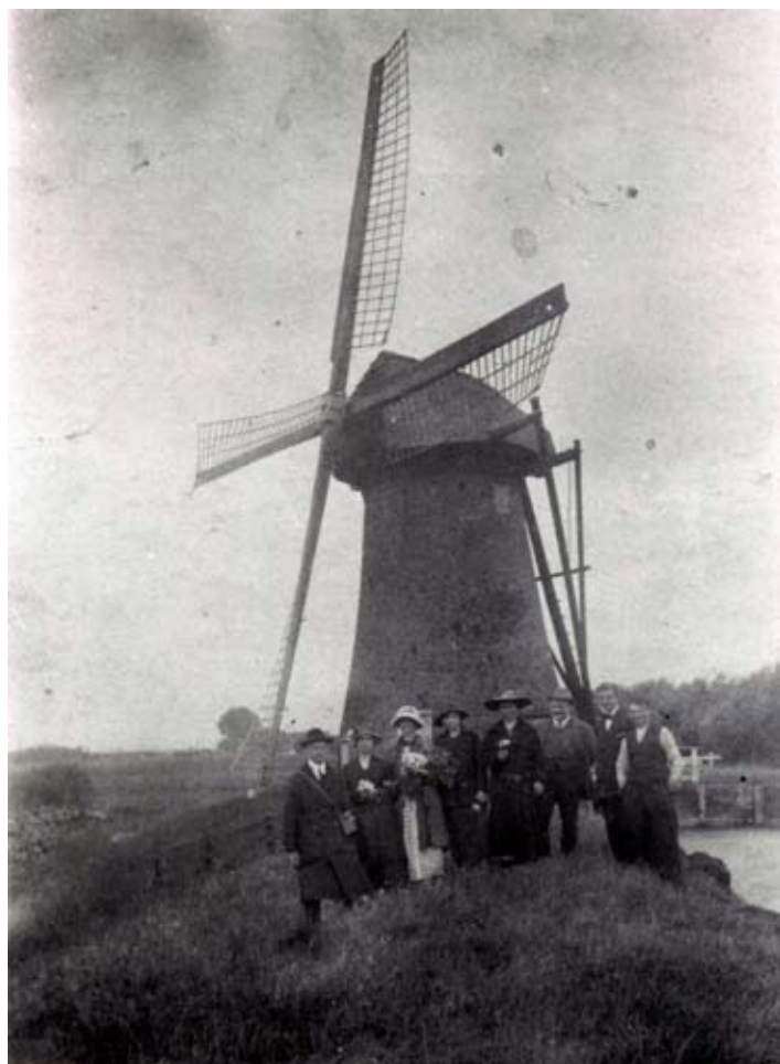
Op deze foto is duidelijk is te zien dat de spuitbalk midden in de kap ligt. Dit gezelschap staat voor de Pendrechtse Molen ergens tussen 1924 en 1933. Deze datering is te maken, omdat aan de beschoeiing te zien is dat de molen al wel hulpbemaling heeft, terwijl het kruis nog niet verdekkend is. (Foto archief Pendrechtse Molen)
