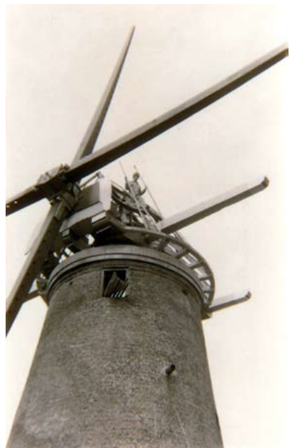
Foto van het werken aan de nieuwe kap in oktober 1976. (Foto J.L.J. Tersteeg)
