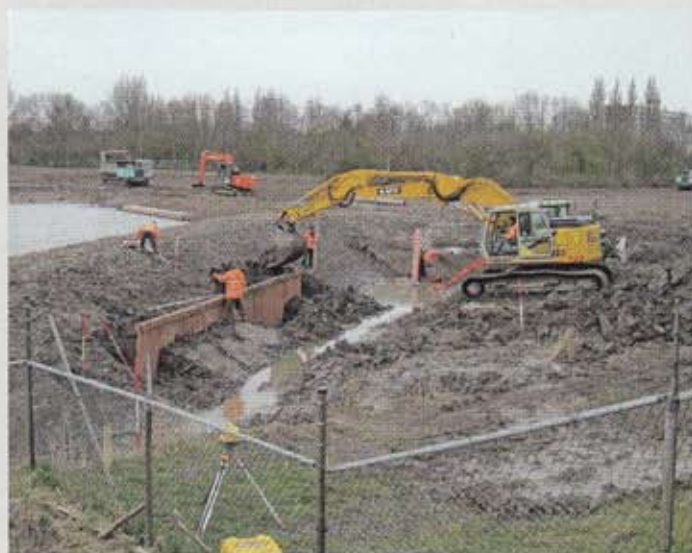
▲ De aanleg van de cascade (foto 3 april 2015).
