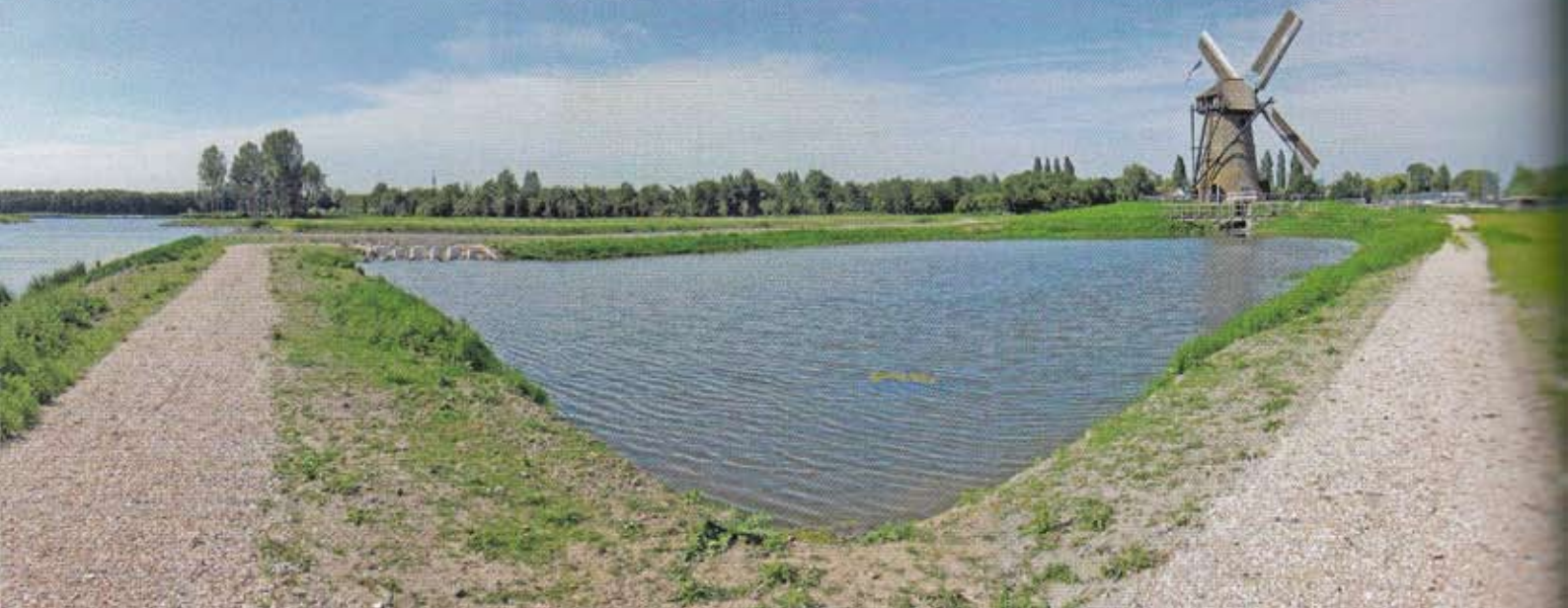
▲ De maalkom met linksboven de overstort (foto 12 augustus 2015).
