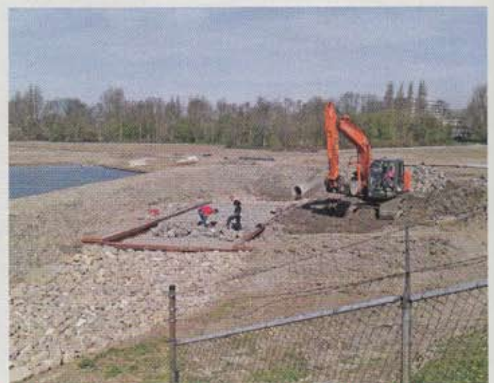
▲ Voor en achter de cascade liggen stenen en in de cascade liggen basaltblokken om het water te laten bruisen (foto 14 april 2015).
