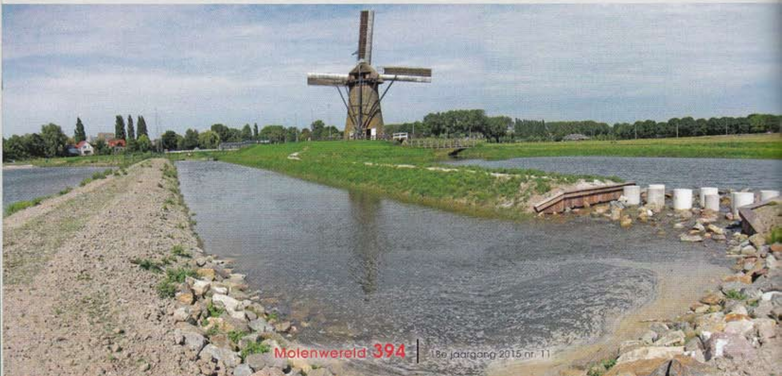
▼ Rechtsboven de maalkom, rechtsonder de overstort en links de watergang naar de cascade (foto 12 augustus 2015).
