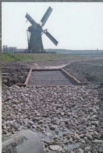
▲ Een lege cascade met uitloop en linksonder de afvoerduiker (foto 10 april 2015).
