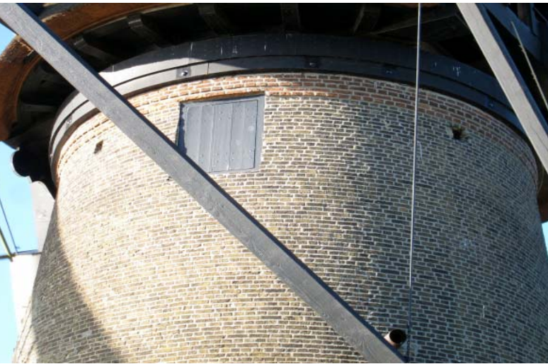
Afb. 24. Het 'teerluik' met aan weerszijden een 'steiger-gat'. (Foto auteur, 17 januari 2015)
