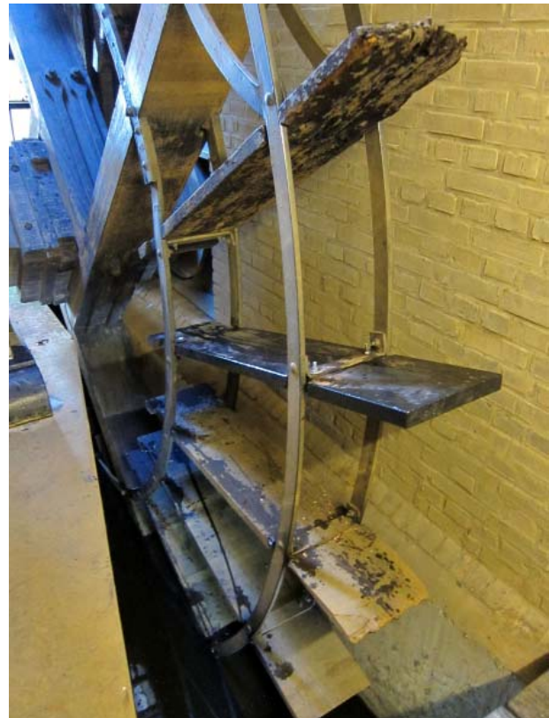
Afb. 26. Bij de verplaatsing van de molen is het scheprad ongeveer twee meter dieper dan voorheen onder het molenerfaangebracht. (Foto Leon Glorius, 16 mei 2011)
