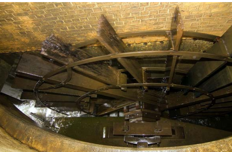
Afb. 26. Bij de verplaatsing van de molen is het scheprad ongeveer twee meter dieper dan voorheen onder het molenerfaangebracht. (Foto Leon Glorius, 16 mei 2011)
