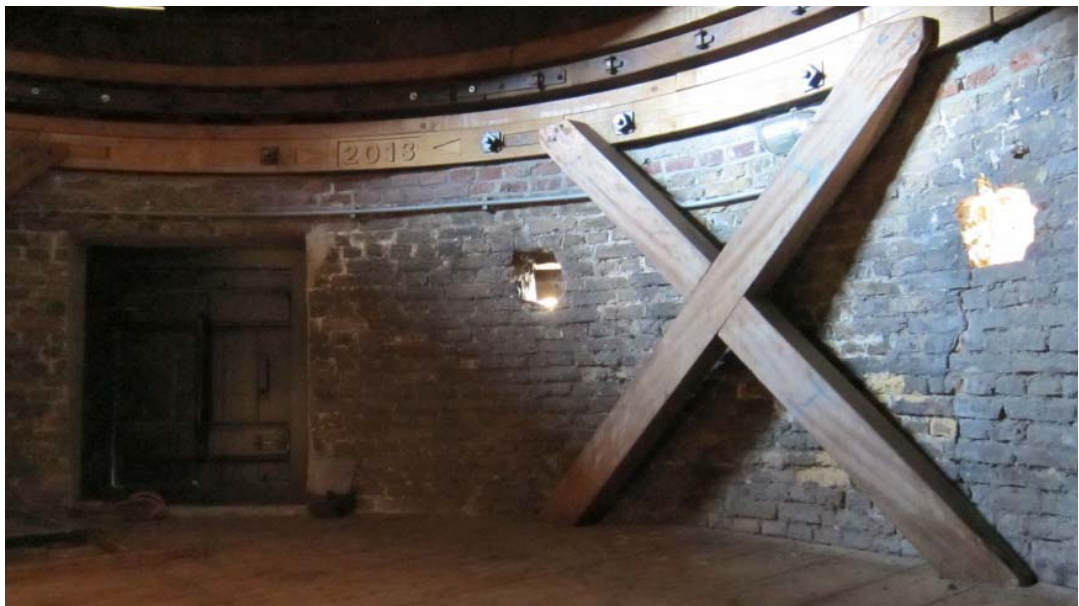
Afb. 23. Een opname op de kapzolder met links het 'teerluik' en rechts aan beide kanten van het kruis om de kruivloer te verankeren twee 'steigerboten'. (Foto auteur, 17 januari 2015)
