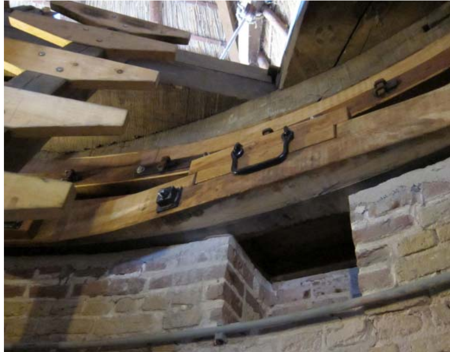
Afb. 22. Op deze opname van onderaf is duidelijk zichtbaar, dat de kruivloer ter plaatse van de rollensluis verbreed is. (Foto auteur, 31 januari 2014)
