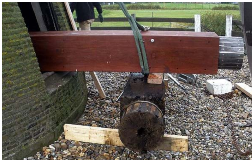
Afb. 28. De oude en de nieuwe houten wateras van de Pendrechtse Molen. (Foto Jan Althof, 21 oktober 2008)
